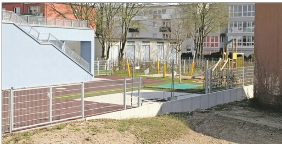
Weil die Lebenshilfe fest auf den Spielplatz nebenan vertraute, ließ sie bereits ein Tor (links) in den Kita-Zaun bauen. Zur Rechten steht die alte Sporthalle der Max-Jäger-Schule, die abgerissen werden soll. Foto: ema
