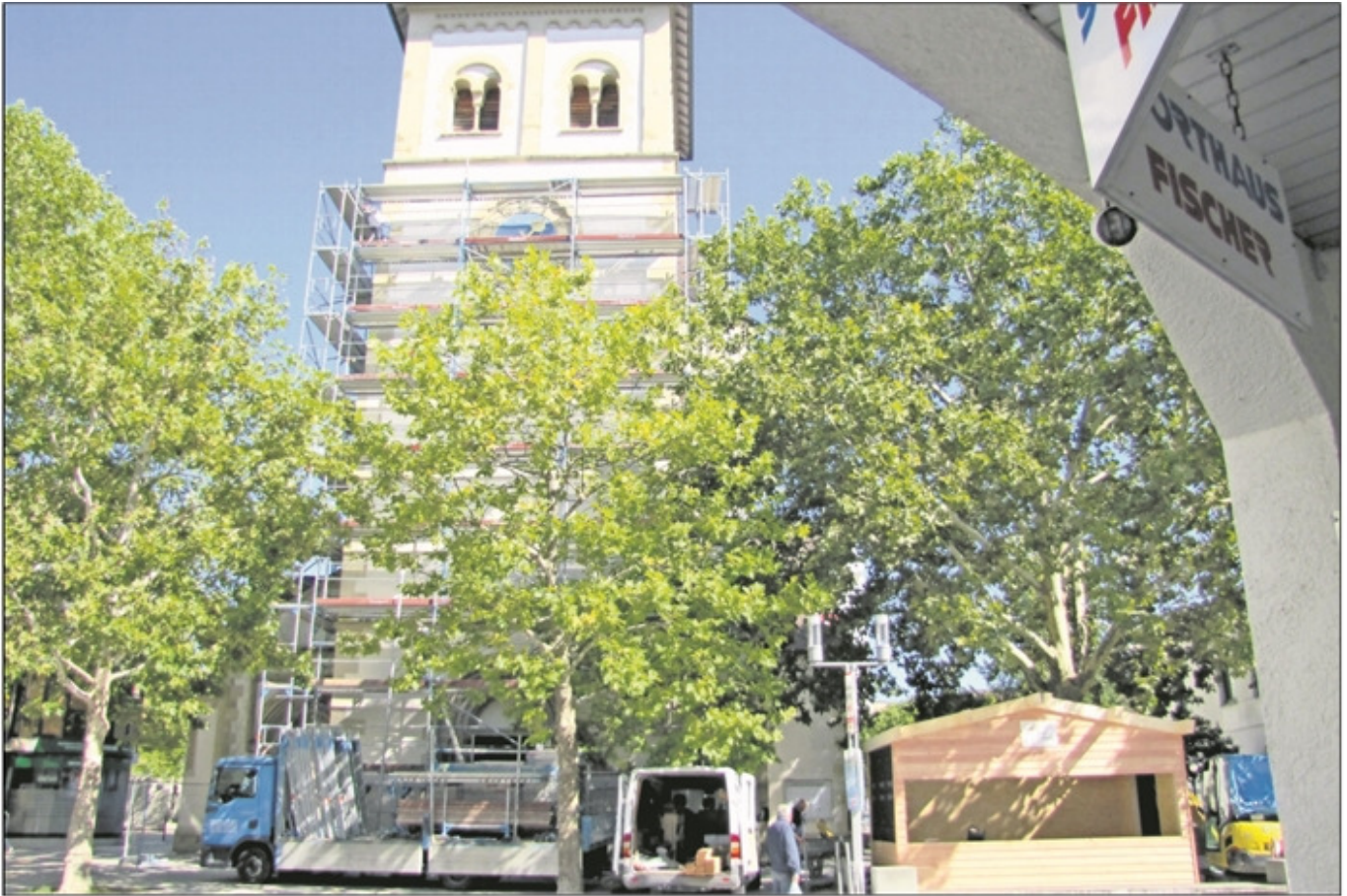
Eingerüstet wird die Kirche St. Josef. Im Rohbau fertig ist das Holzhaus für den „Josefs-Treff“ (rechts).
