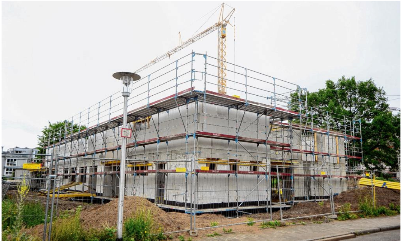
ZWEI STOCKWERKE STEHEN: Bei der Kindertagesstätte „Pünktchen“ im Zay neben der ehemaligen Max-Jäger-Schule geht es rasch voran. Ende des Jahres soll das Richtfest sein. Foto: Collet
